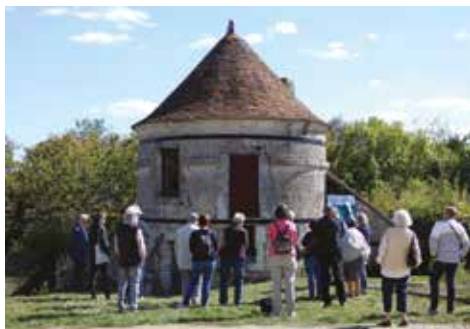
Four à pain de l'ancien logis des Hauts de Montrieux à Naveil
