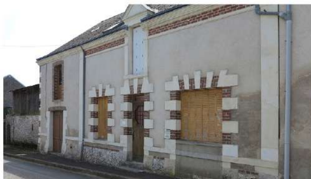
Assemblage de matériaux : tuffeau, moellons, briques
