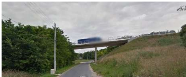
Franchissement du vallon de Chanteloup par la D957 (rocade de Vendôme). L'ouvrage architecturalement intéressant mais manque d'intégration, et participe à la fragmentation de l'espace.
