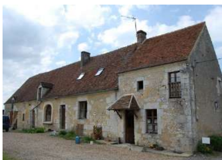
Habitat typique du Perche, moellons de tuffeau, enduits jaune ocre © école du paysage/INSA CVL
