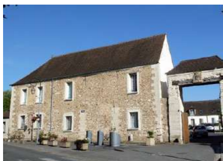
Habitat beauceron, moellons calcaires, constructions austères et massives © école du paysage/INSA CVL
